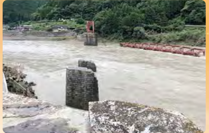
九州豪雨で流失したJR肥薩線『球磨川第一橋梁』
