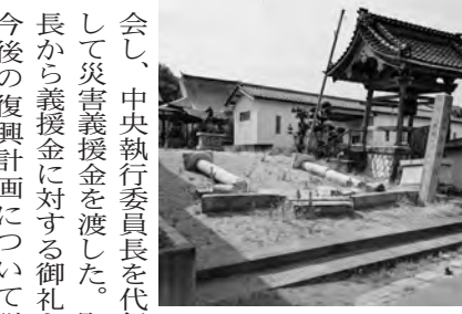
地震の被災状況
